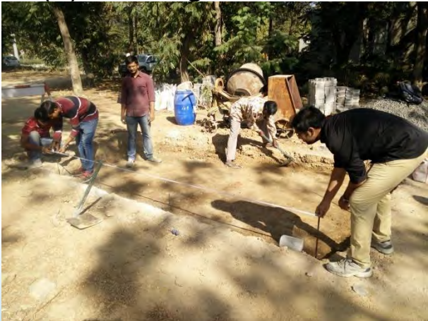
(d) Levelling for kerbing around (e) laying
